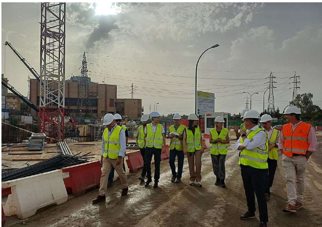
Las obras de la nueva estación de bombeo del Tamarguillo siguen su curso. (CHG)
