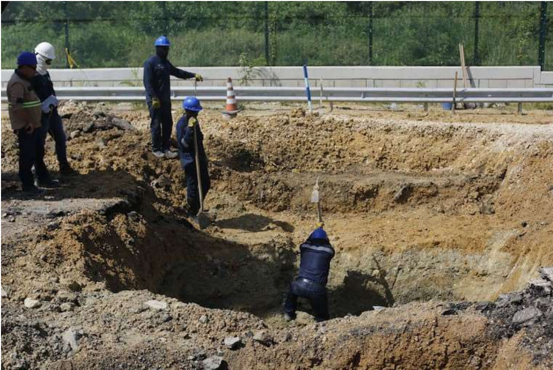
Acuacar avanza en obras de reparación de la tubería en Mamonal. // Foto: Luis Eduardo Herrán - El Universal
